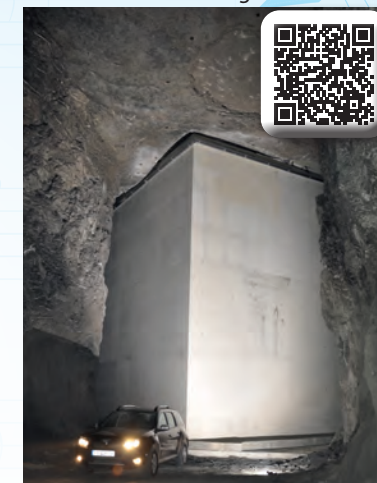
Einbau von rückverankerter Schalung von fast 600 Quadratmetern, damit ein 1900 m3 großer Betonquader mit einer mehr als 100 Meter langen Pumpenleitung in 72 Stunden am Stück gegossen werden konnte.
